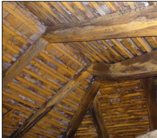
6. fotó A 21-es vápaszarú beázása a hibás kúpcserép fedés miatt
