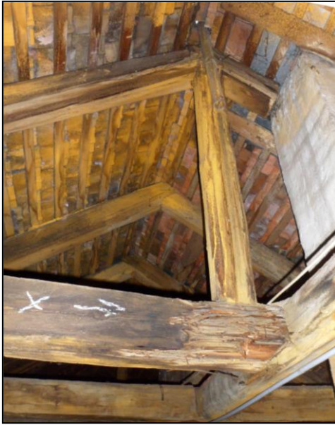
9. fotó A 13/1-es antennaáttörés miatt beázó, megroppant, gombás csomópont,
