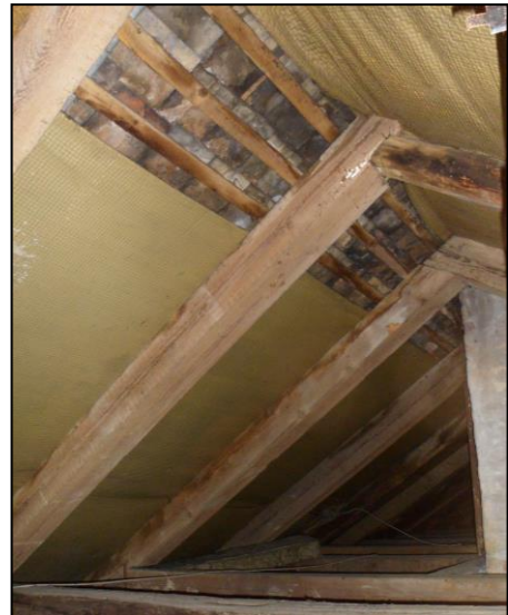
3. fotó Fóliaborítás a beépített tetőrész
