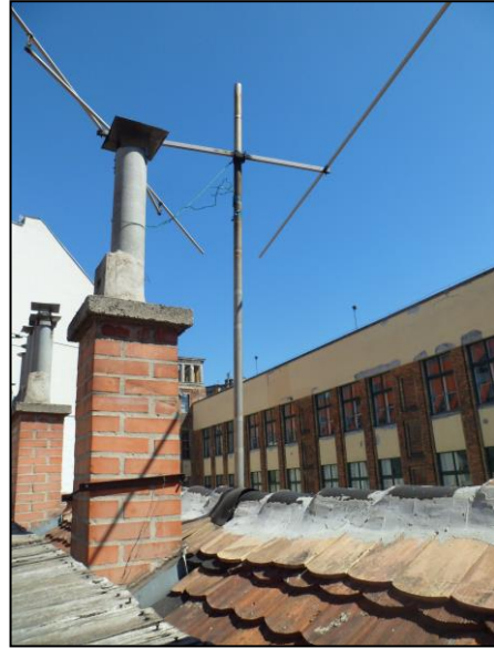
10. fotó A 13/1-es csomópont hibás antennaáttörése
