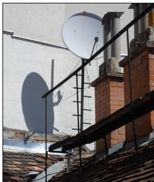
8. fotó A 8-as vápaszaru antennaáttörése
