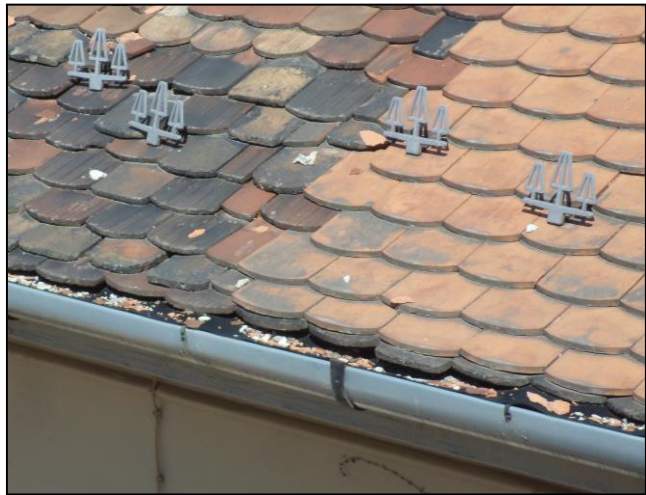
2. fotó Töredezett cseréndarabok az ereszcatornában
