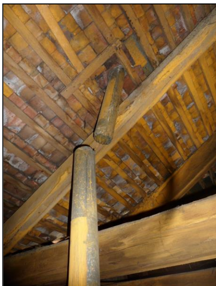
11. fotó Szétcsúszott ejtővezeték
