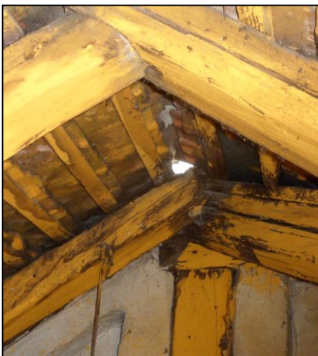
4. fotó A 2-es főszaruállás csúcsa belülről
