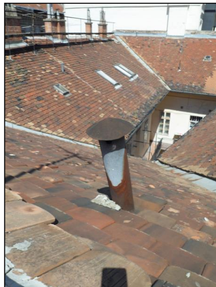
12. fotó A 18-as szaruállás elmozdult, javításra szoruló ejtővezetéke
