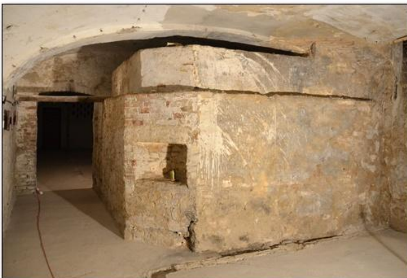
5. ábra. A kibontott kemence hátfala
